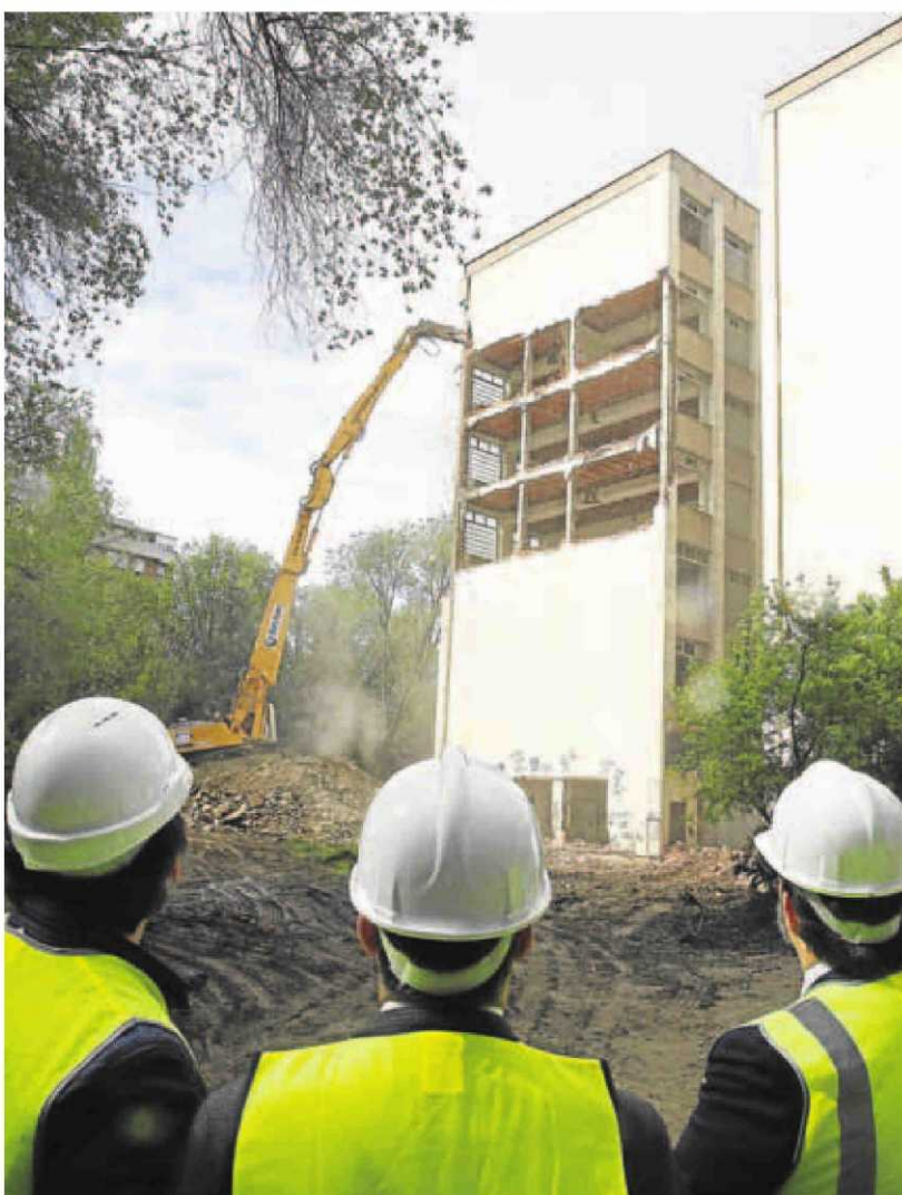
El rector y su equipo observan las tareas de derribo de la torre. :: GABRIEL VILLAMIL
